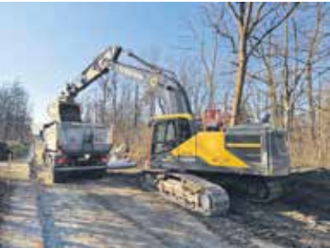
Obnova Preloške ceste v Ihanu
