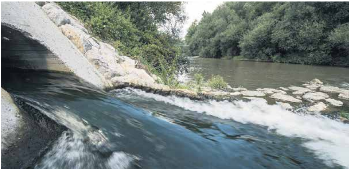
Domžale - Kamnik: iztok prečiščene odpadne vode v Kamniško Bistrico
