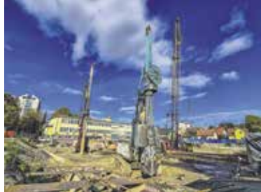
Na gradbišču ZD Domžale potekajo zahtevna pripravljalna dela za izvedbo temeljenja objekta.
